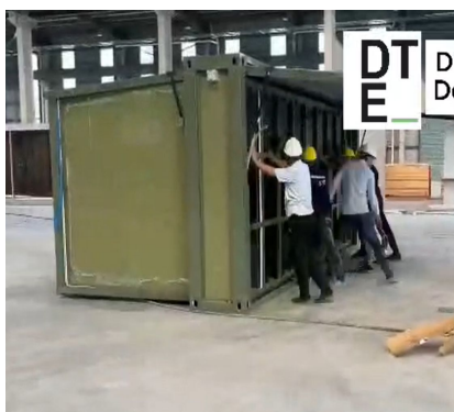
4 Desplegar los muros laterales (ala 1)
