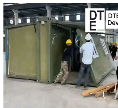
6 Abrir muro fachada (ala 2)
