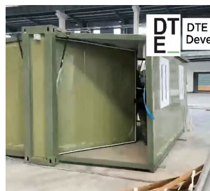
7 Desplegar los muros de fachada (ala 2)
